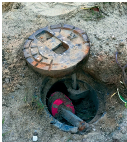
Abb. 2: Betätigung nicht möglich, Straßenkappe vermutlich durch Bauverkehr verschoben
