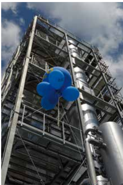
Abb. 1: Aufbau Pilotanlage EE-Gas
