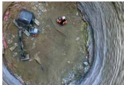
Blick in die 21 Meter tiefe Startgrube
