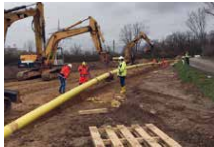
Absenken der Rohre in den Leitungsgraben
