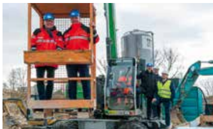
ESWE-Vorstände besichtigen die Baustelle
