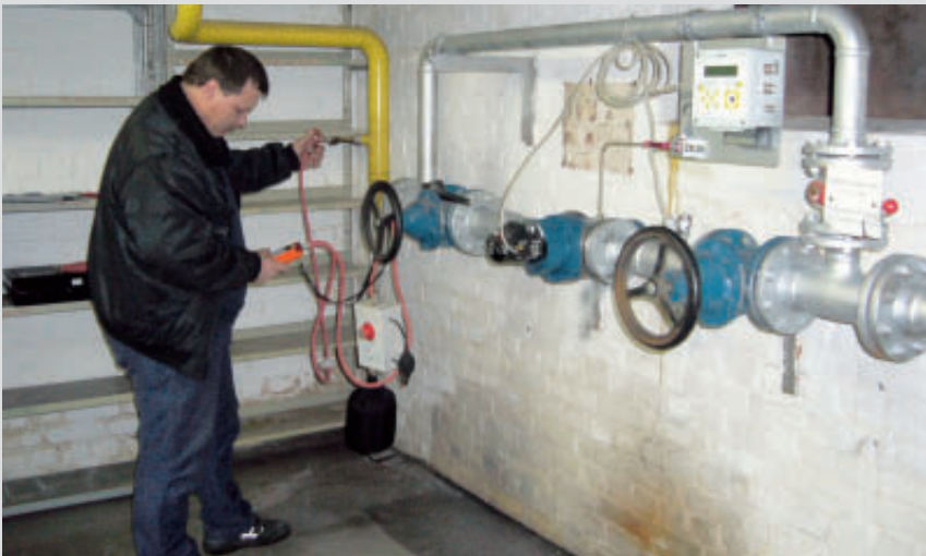
Gebrauchsfähigkeitsprüfung mittels elektronischem Leckmengenmessgerät und Gasblase zum Nachspeisen von Gas bei einem vermuteten Leck
