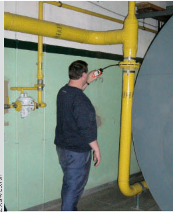
Prüfen der Gasleitung mittels Gas-spürgerät
